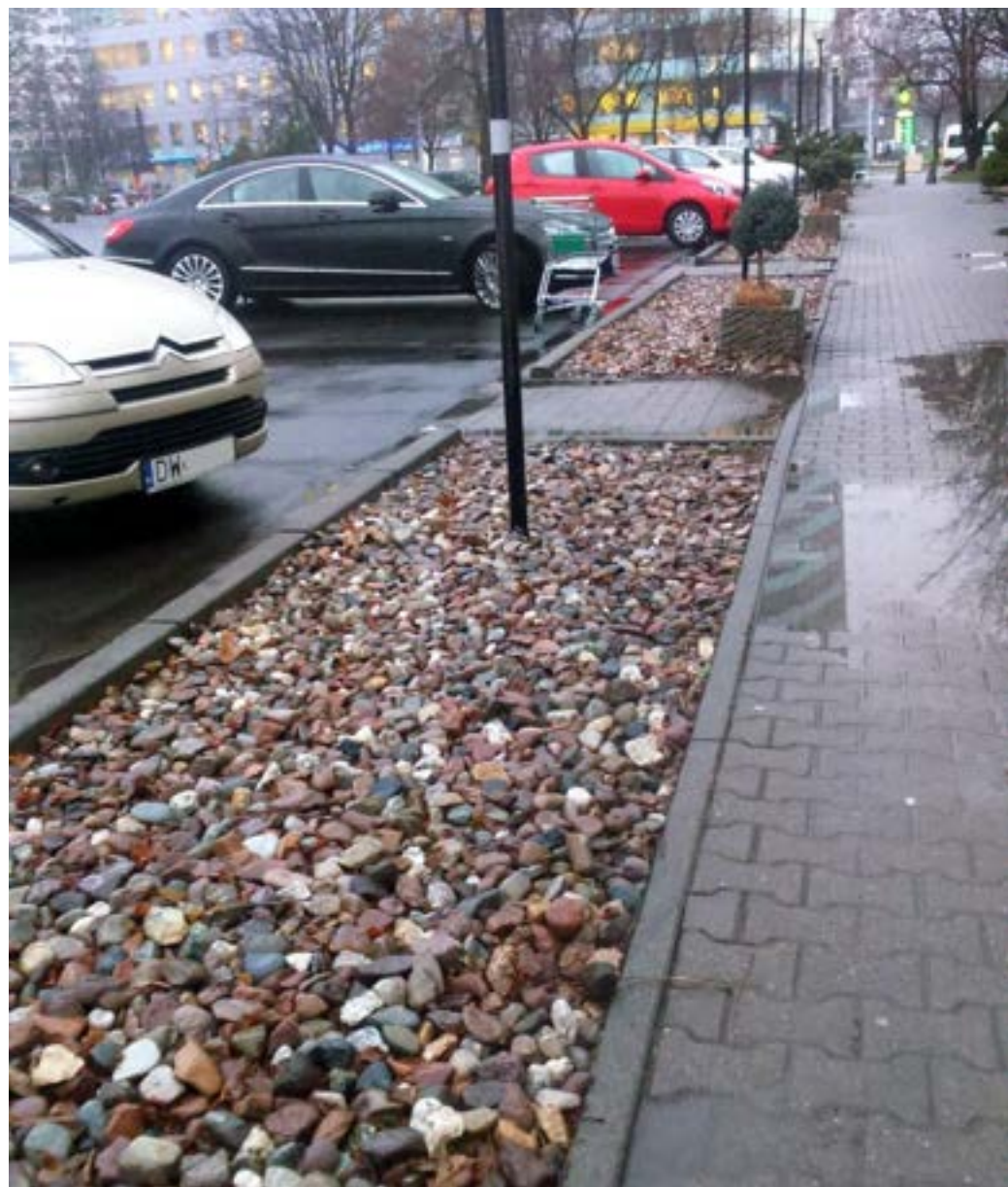
Rów infiltracyjny wykorzystany do odwodnienia parkingu, Wrocław (fot. E. Burszta-Adamiak)
